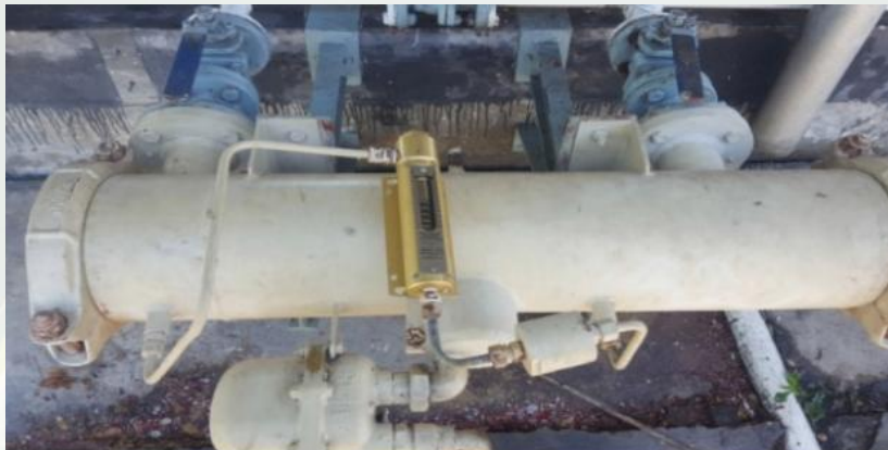
Gambar 25 Pemasangan Sistem Filtrasi di Tangki Own Used Solar
