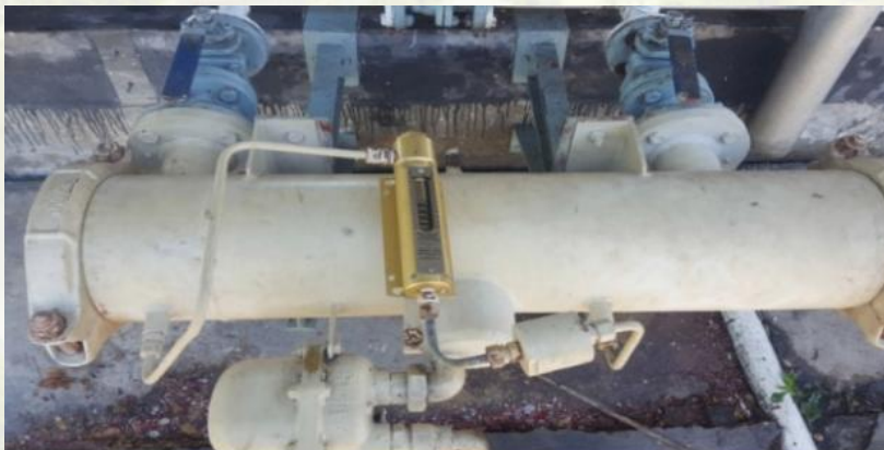
Gambar 24 Pemasangan Sistem Filtrasi di Tangki Own Used Solar
