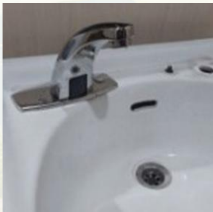
Gambar 46 Kran Air Otomatis di BPG
