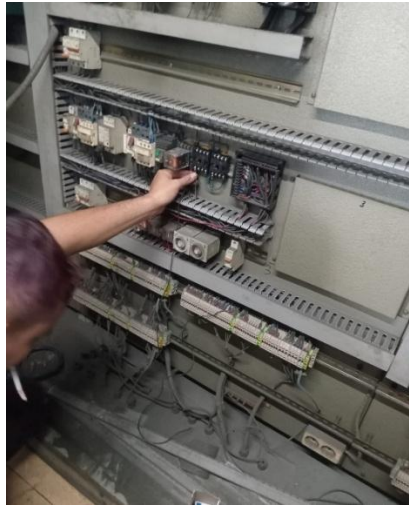
Gambar 7 Proses Pemasangan Timer pada Unit Pyrorefining
