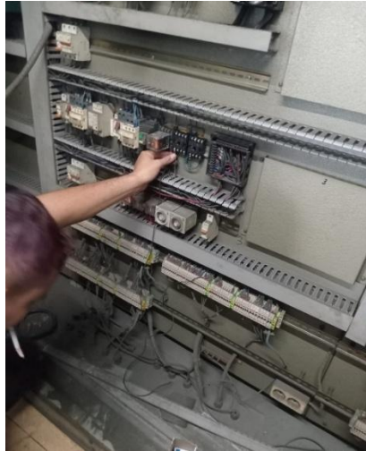
Gambar 7 Proses Pemasangan Timer pada Unit Pyrorefining
