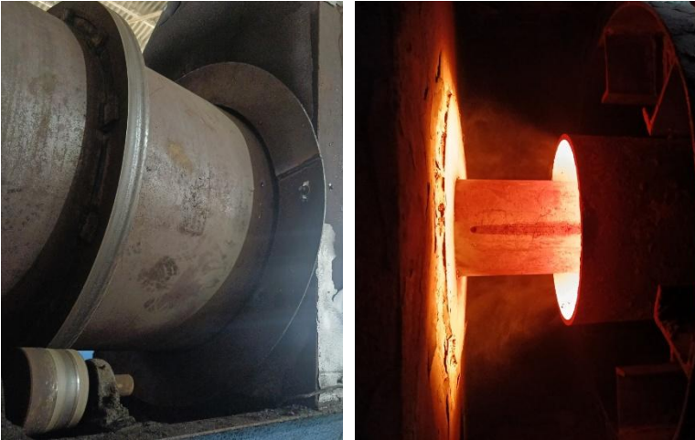
Gambar 4 Pemasangan Ring Plat dan Lorong Api pada Rotary Dryer
