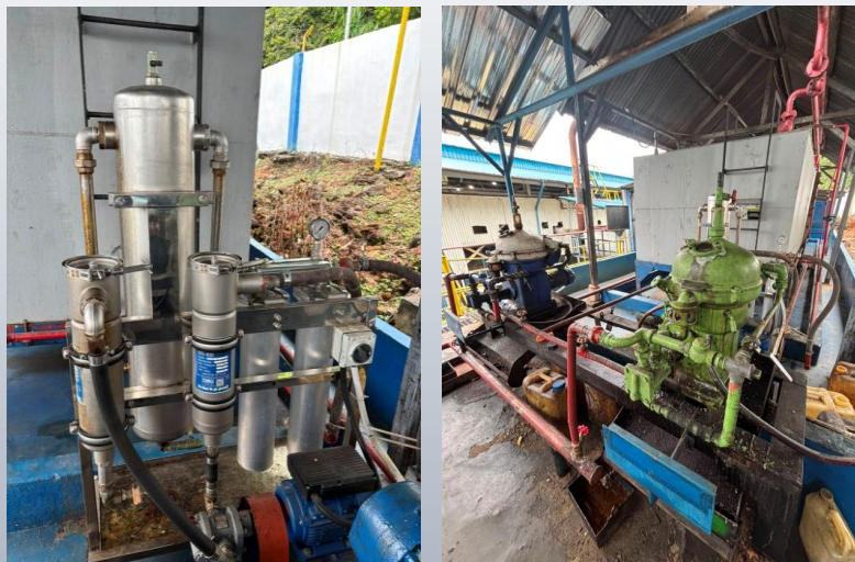
Gambar 28 Penerapan Metode Sentrifugasi pada Mesin Alfa Laval
