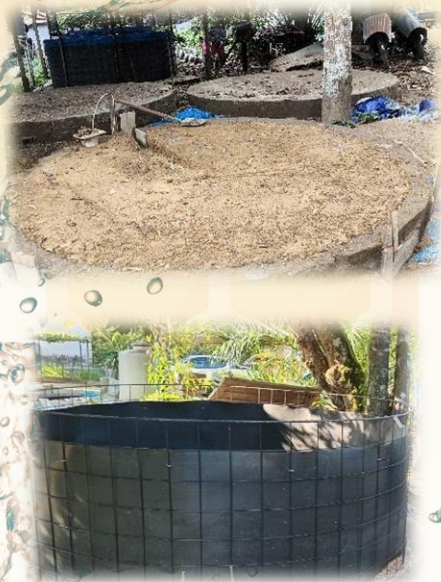
Gambar 24 Pembangunan Pondasi dan Pemasangan Kerangka Bioflok
