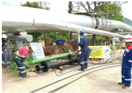
Dokumentasi Proses Pembangunan Jalur BTCS
