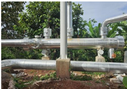
Dokumentasi Penambahan Jalur BTCS
