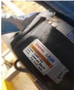
Dokumentasi Proses Pengujian Hydro Test pada Pipa Baru
