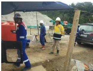
Dokumentasi Proses Pengujian Hydro Test
