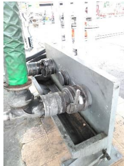
Jalur Bypass Menuju Sumptank
