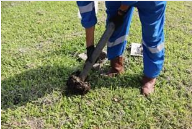
Pembuatan lubang biopori menggunakan alat bor tanah sebagai langkah awal program MOLAKOM
