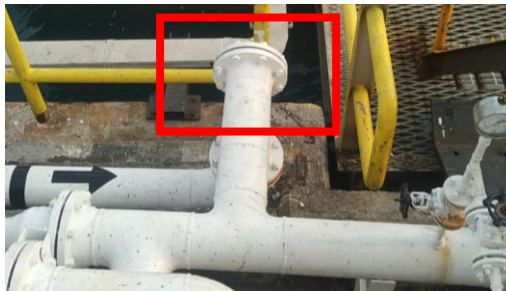
Dokumentasi Instalasi Furcon (Future Connection Pipe) pada jalur pipa penyaluran BBM
