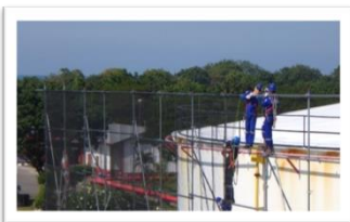
Gambar Pemasangan Water Shield
