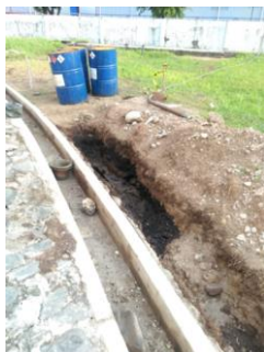
Gambar proses Pembuatan Jalur Intertank
