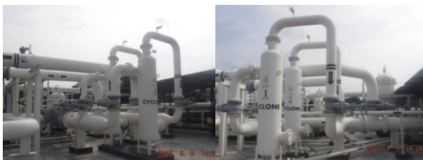
Penggunaan Cyclone Filter sebagai Pengganti Filter Water Separator (FWS)
