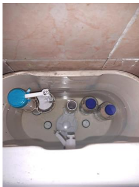
Peletakan botol berisi pasir di dalam tangki kloset
