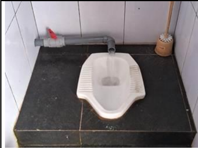
Flushing Kloset Kamar Mandi Menggunakan Air Bekas dari Wastafel
