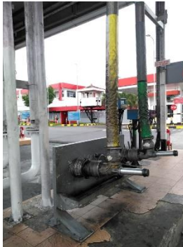
Jalur Bypass Menuju Sumptank
