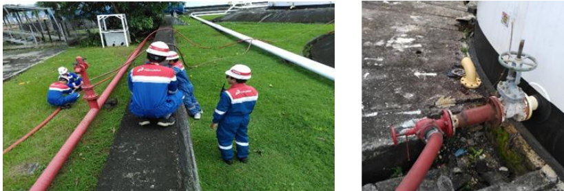
Gambar 29 Penggunaan Air Kolam PMK untuk Kegiatan Hydrostatic Test pada Struktur
