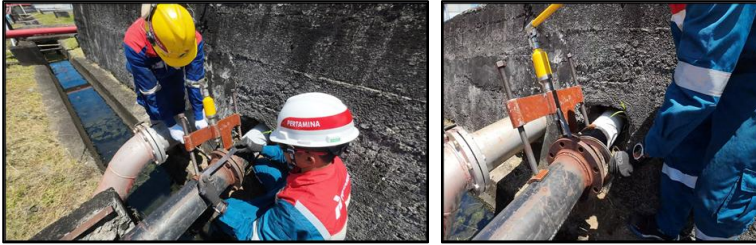
Gambar 28 Meningkatkan Kehandalan pada Pemasangan Pipa Flange to Flange dengan Alat Bodong 2.0
