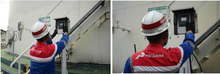
Gambar 10 Operator Pemeliharaan Tangki Penyimpanan melakukan pemantauan melalui monitor pada sistem ATANG
