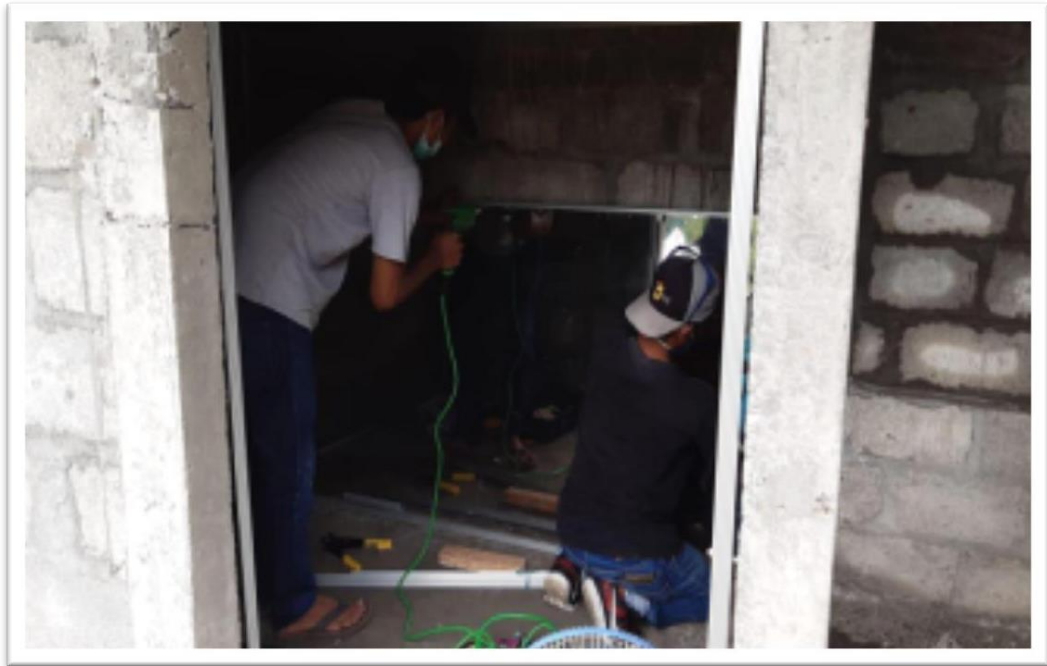
Gambar 7. Pemasangan Glasswool dan Pelapis Stainless Steel pada Ruang Sterilisasi
