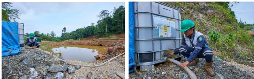
Gambar 21 Penambahan Koagulan Pada Settling Pond
