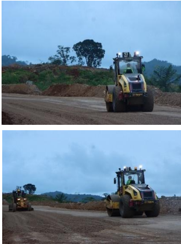
Gambar 18 Perataan Jalan Hauling
