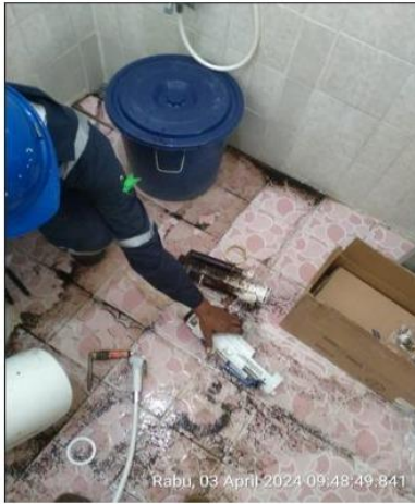
Gambar Penggantian Dual Flush Toilet
