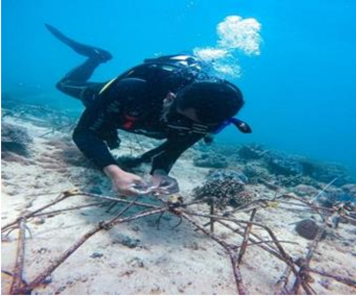
Gambar 9. Proses Pemasangan KORALIS, Kubah Inovatif sebagai media Transplantasi Terumbu Karang
