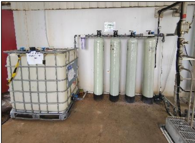
Gambar 3. 4 Sistem filtrasi SADAH (Sistem Aqua Demin Area Karaha)
