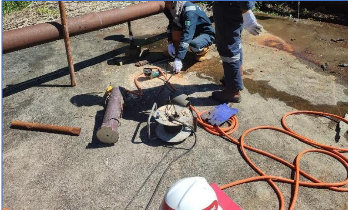
Gambar 1. 3 Proses Pemotongan jalur pipa 6 inci bekas pengeboran untuk di modifikasi dengan pemasangan elbow 6 inci
