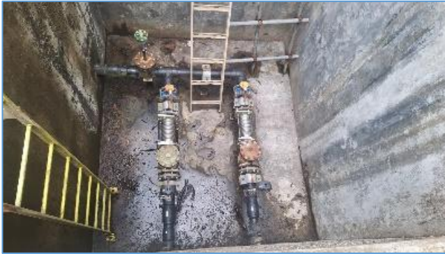
Gambar 2. 3 Water Pumping Supply Untuk Supply Dari Mata Air Ke Water Reservoir
