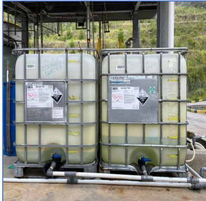
Gambar 4. 8 Tanki penampungan biocide N7330 pada sistem SIDOCTOR berukuran 2 x 1000 liter
