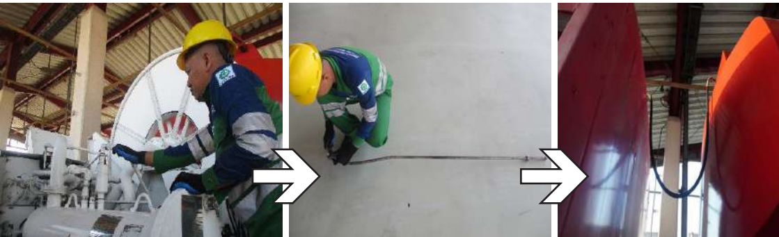
Gambar 3. Modifikasi jalur Pressure Relief Valve pada Refueller DPPU Juanda
