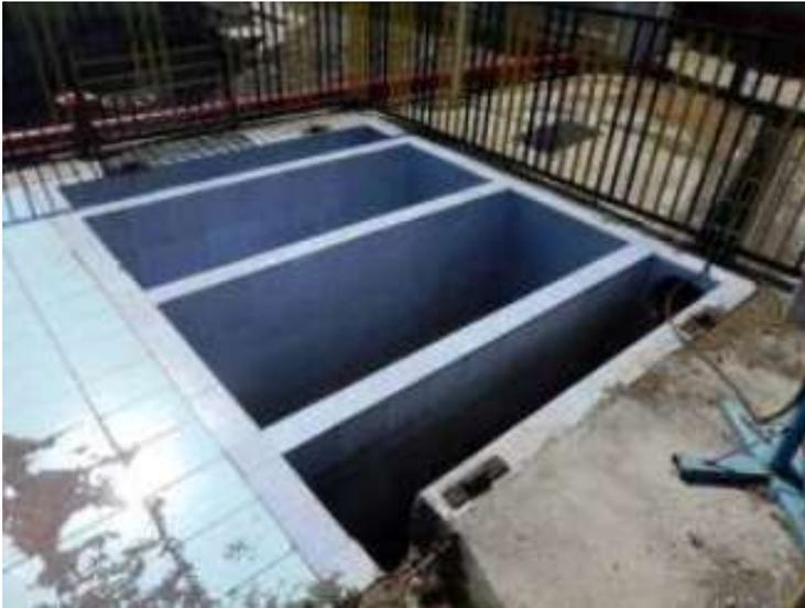
Gambar 51 Implementasi Program Rekonfigurasi Baffle pada API Separator
