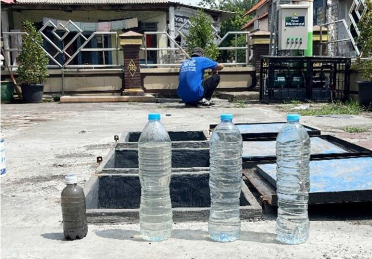
Hasil Pengolahan air limbah menggunakan IPAL Komunal Sumber: Dokumentasi PT Pertamina Patra Niaga AFT Juanda 2023
