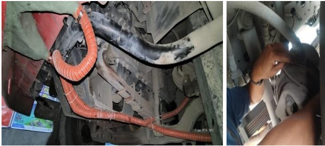
Gambar 25. Pemasangan Cooling duct
