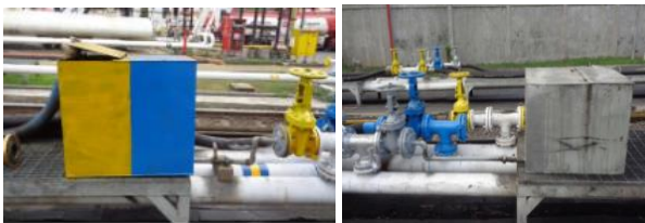
Gambar 46. (a) Limbah Sludge Tanpa Pengelolaan (b) Handling Ceceran Minyak Kotor dengan Containment Settling Box
