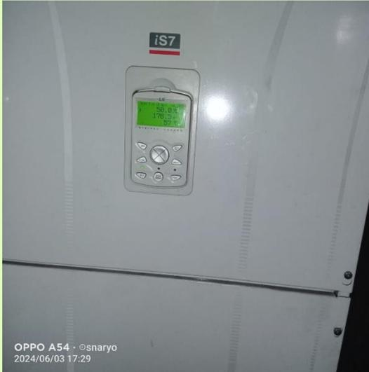
Pemasangan Inverter pada ID fan Boiler
