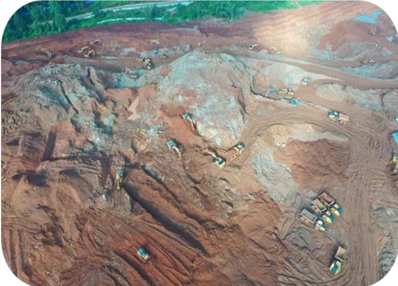
Dalam proses pengangkutan atau yang dikenal dengan *Hauling* PT Hengjaya Mineralindo menggunakan *Truck* yang bertujuan untuk mengangkut *Ore* menuju *Stock Pile* untuk dilakukan pengujian sebelum *Ore* tersebut siap untuk dikirim ke proses selanjutnya.
