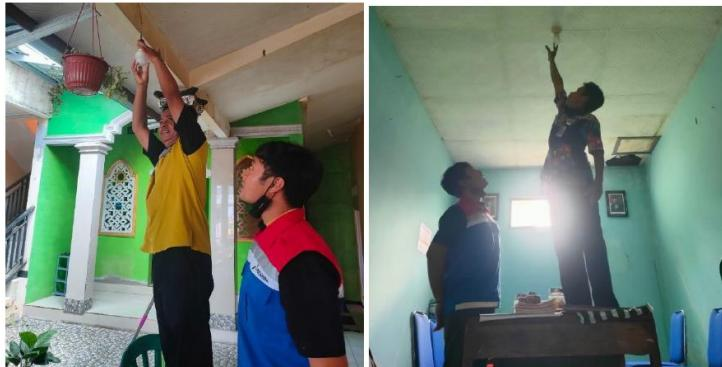
**Gambar 5.1 Penggantian Lampu TL Menjadi Lampu LED**
