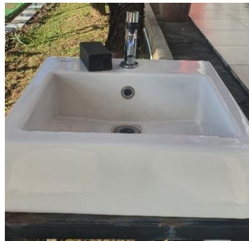
Gambar 3.1 Implementasi Kran Sensor di Rumah Potong Abadi Farm
