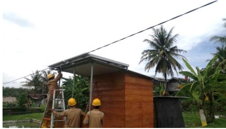
Gambar 2.5 Pemasangan Solar Cell di Area Pemberdayaan Masyarakat
