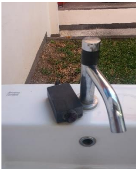
Gambar 3.1 Implementasi Kran Sensor di Rumah Potong Abadi Farm
