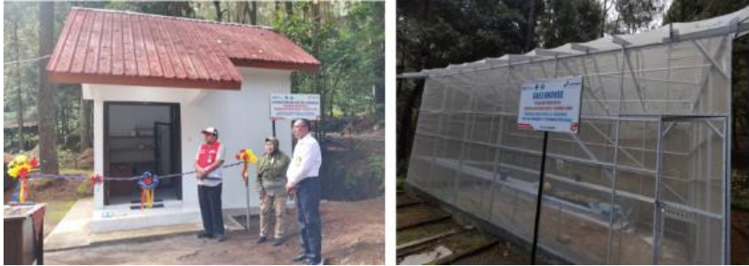
Gambar 30 Pembangunan laboratorium kultur jaringan dan green house anggrek
