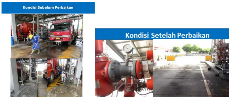
Gambar 3.1 Kondisi sebelum dan Sesudah Perbaikan
