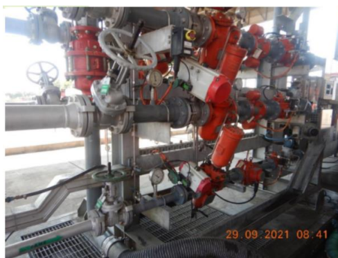
Gambar 5.3 Penggunaan Katup Udara Bertekanan (Pneumatic) pada Filling Shed New Gantry System
