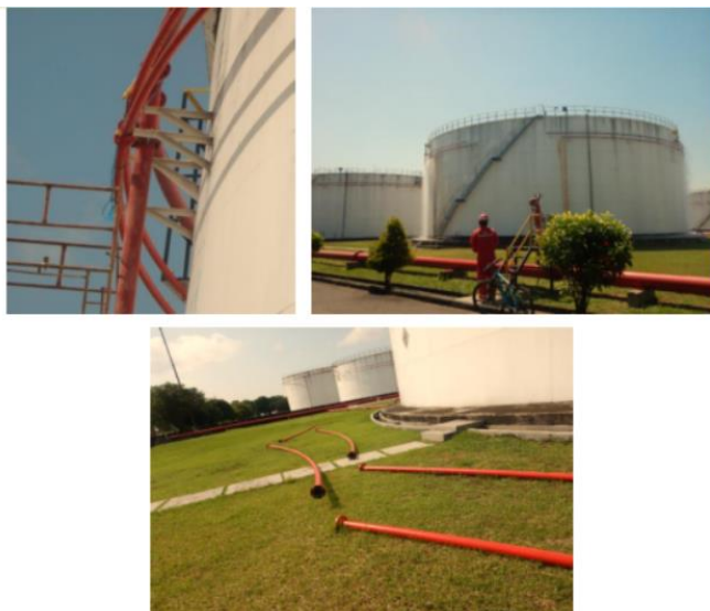
Gambar 3.4 Kegiatan Pemasangan Ring Water Sprayer Tangki Timbun
