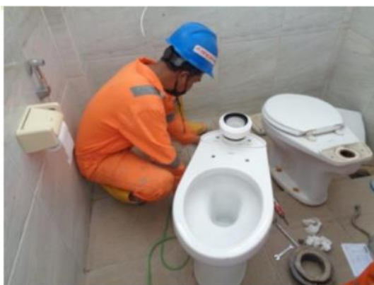
Gambar 3.6 Pemasangan Flow Restrictor pada Komponen Plumbing Kamar Mandi.
